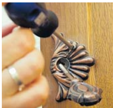
Die Beschläge werden nach der Auswahl vor Ort montiert.
